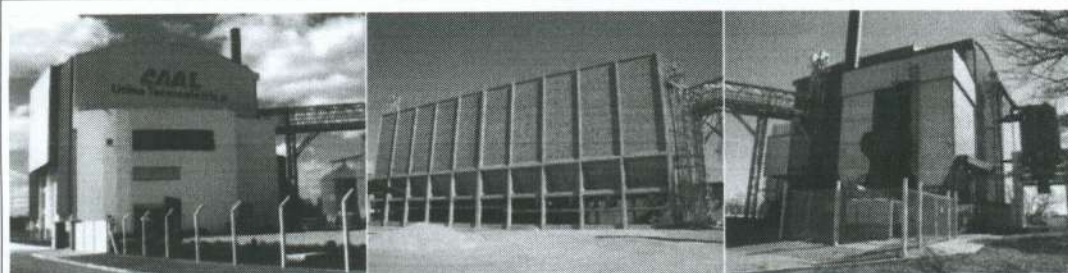
Figura 64 - Usina Termoelétrica da CAAL com base na Casca de Arroz
