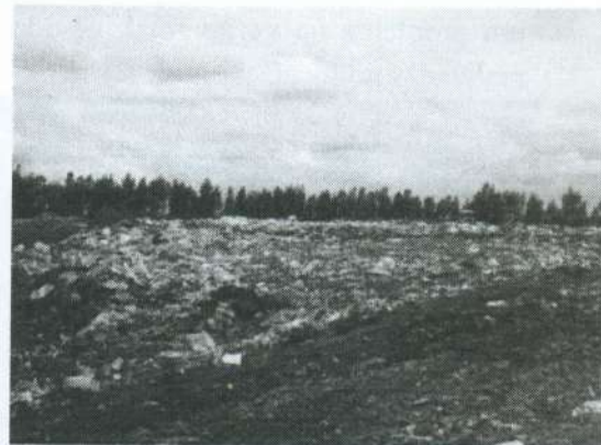
Figura 27 - Acabamento da Célula de Carga do Aterro
