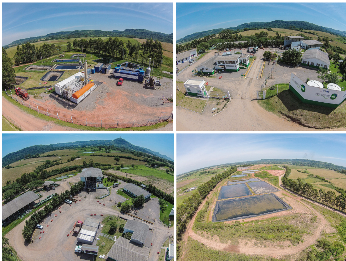
Figura 12: Central de Tratamento de Resíduos, local de destinação dos resíduos de Alegrete.
