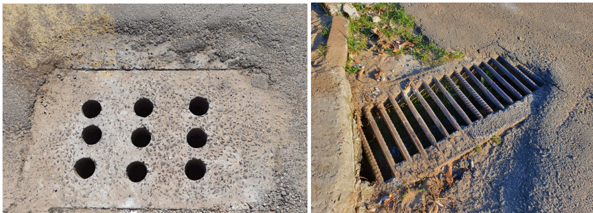
Figura 29: Obras de escoamento e drenagem das águas pluviais.
