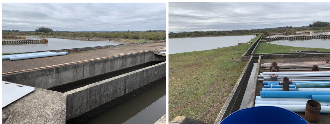
Figura 23: ETE: Canaletas e lagoas, anaeróbia e facultativa.
