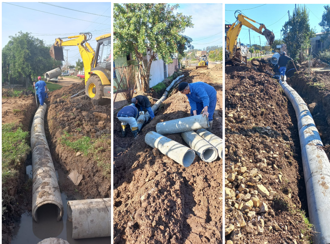
Figura 28: Instalação de tubulação para drenagem das águas pluviais
