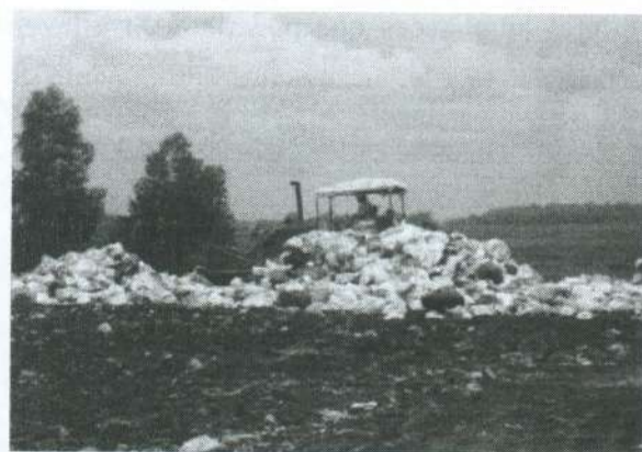
Figura 26 - Processo de compactação dos RSU [21]
