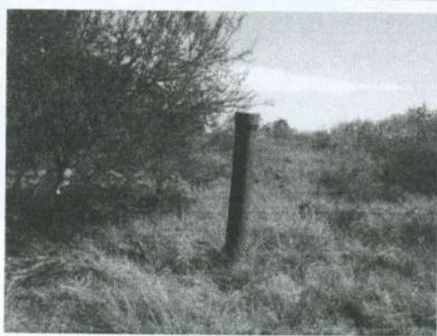
Figura 28 - Tubo metálico usado para de gases
