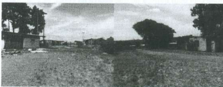
Figura 80 - Ocupação Urbana indevida nas bordas da Antiga Pedreira
